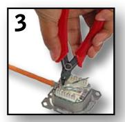
Von der untersten Klemme beginnend mit dem LSA-Anlegewerkzeug die Adern gemäß Farbcodierung auf der Dose anschließen. Die beschriebenen Schritte für den zweiten Port wiederholen. Dose zuschrauben.
