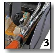
Von der untersten Klemme beginnend mit dem LSA-Anlegewerkzeug die Adern gemäß Farbcodierung auf den LSA-Leisten anschließen.
